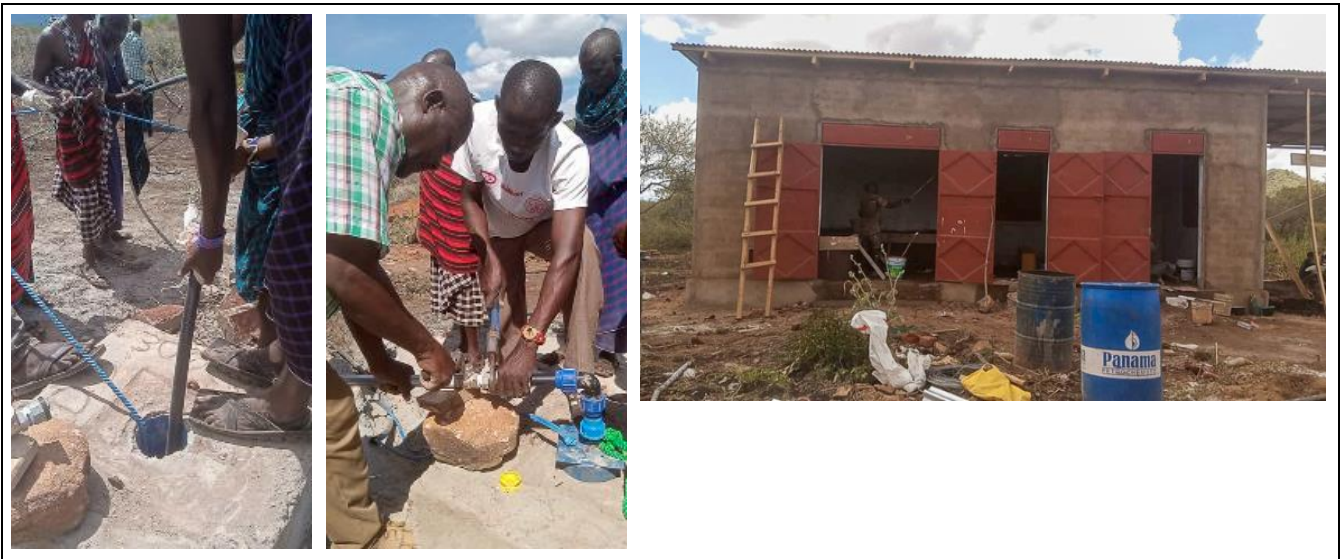
Installation der Tiefpumpe (Tauchpumpe) im 100m tiefen Bohrloch, Bauarbeiten am Pumpenhaus
