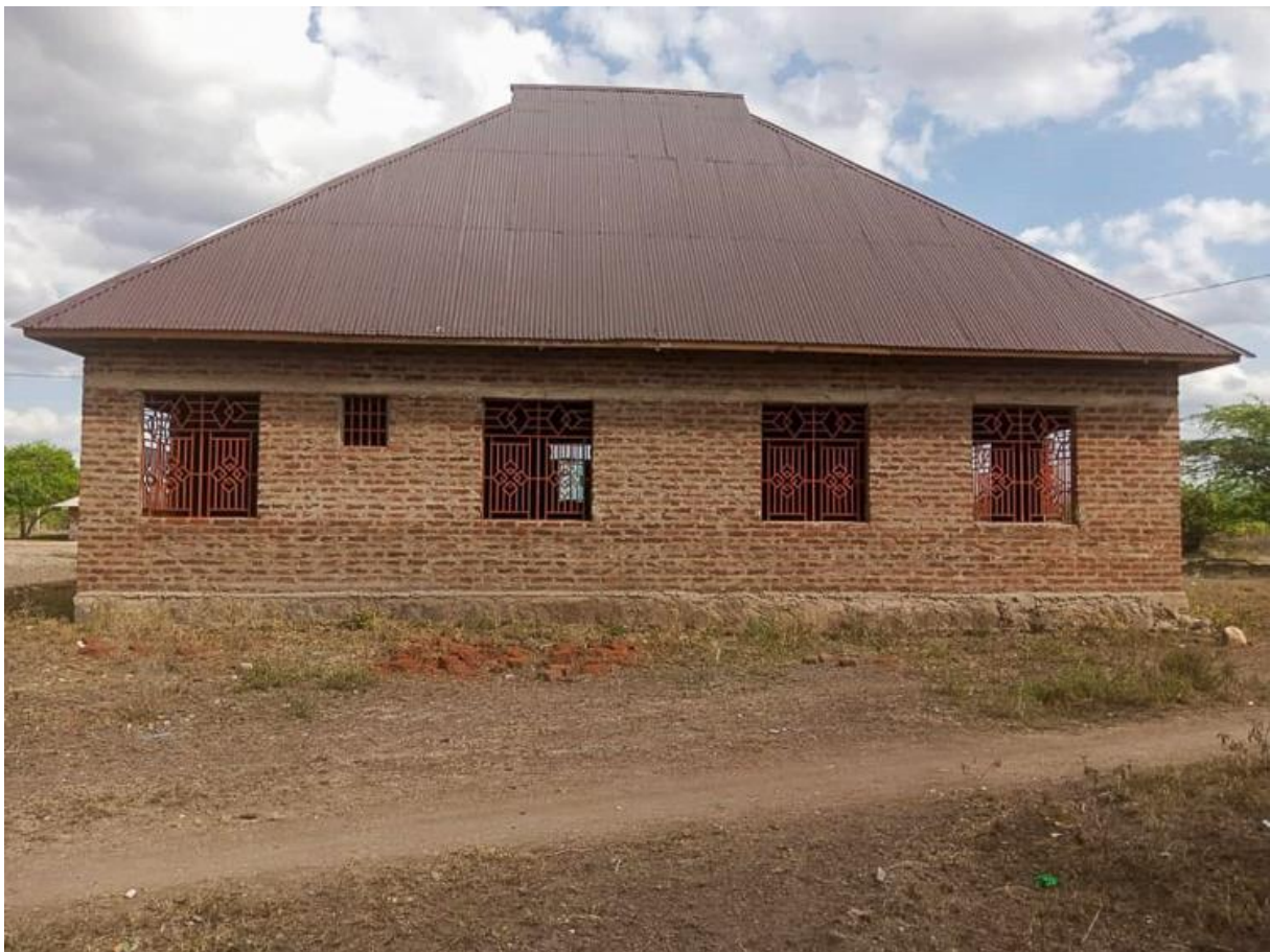
"Toloha Training Center", Bauzustand Anfang Mai 2022
