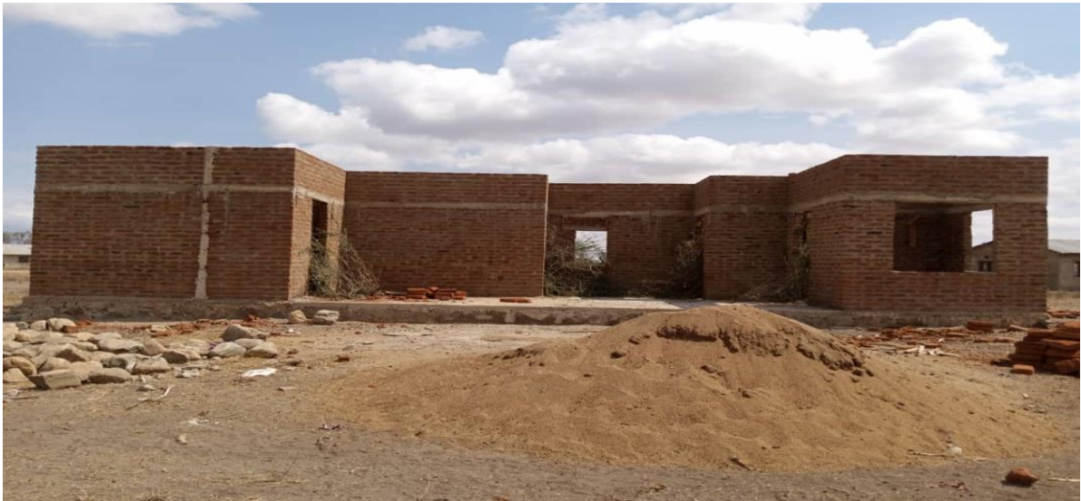
Das Training Center zu Beginn der Bauarbeiten (Mai 2021)
