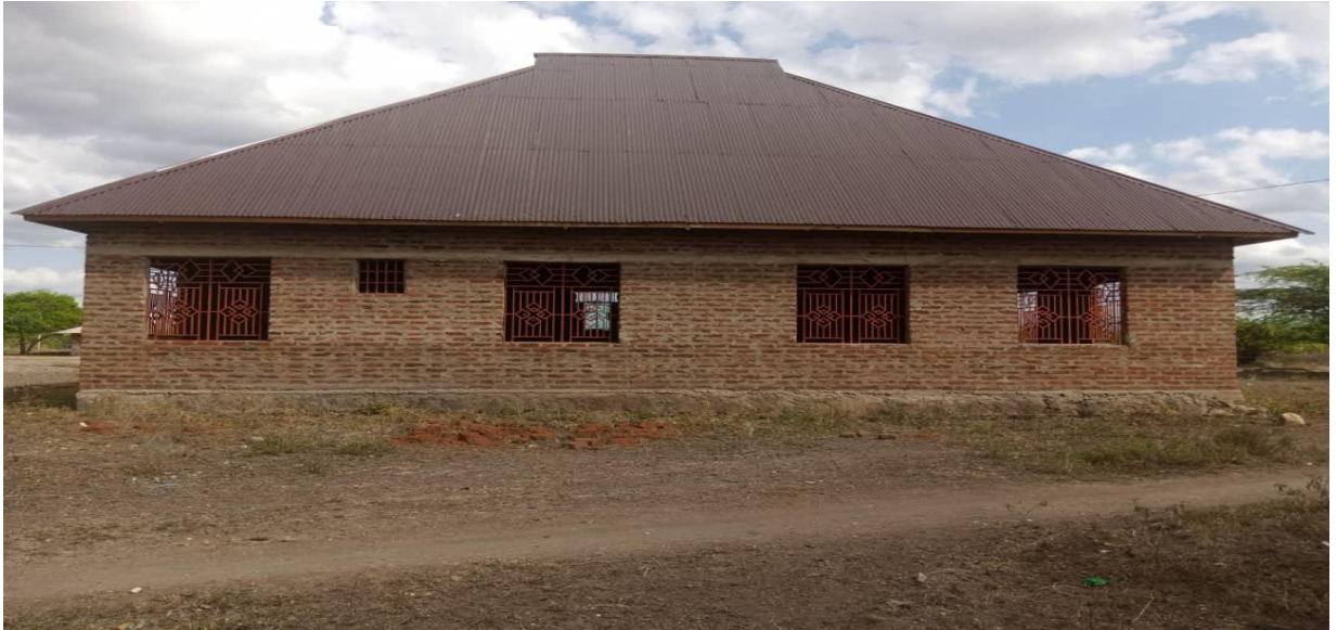
Aktueller Ausbaustand des Training Center (Mai 2022)
