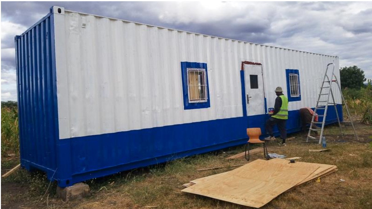
Aufarbeitung des Containers
