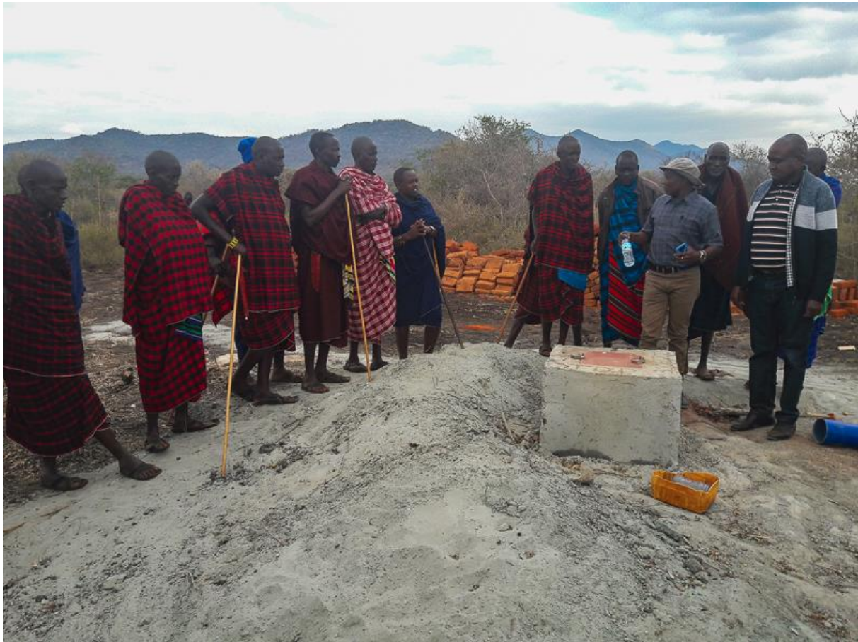
Das versiegelte Bohrloch in Mbaro, rechts im Bild Mwanga MP Mr. Tadayo
