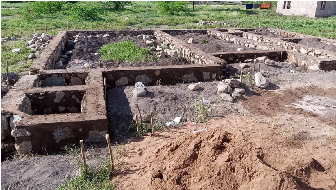
Das Fundament für das Multifunktionsgebäude ist gelegt.
