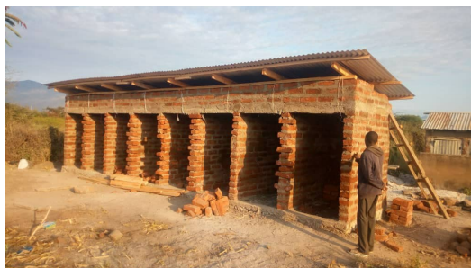
Rohbau des Toiletten-Traktes
