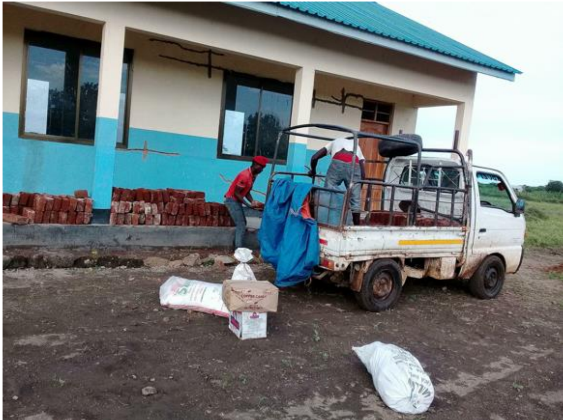
Anlieferung von Baumaterial zur Schadensbeseitigung
