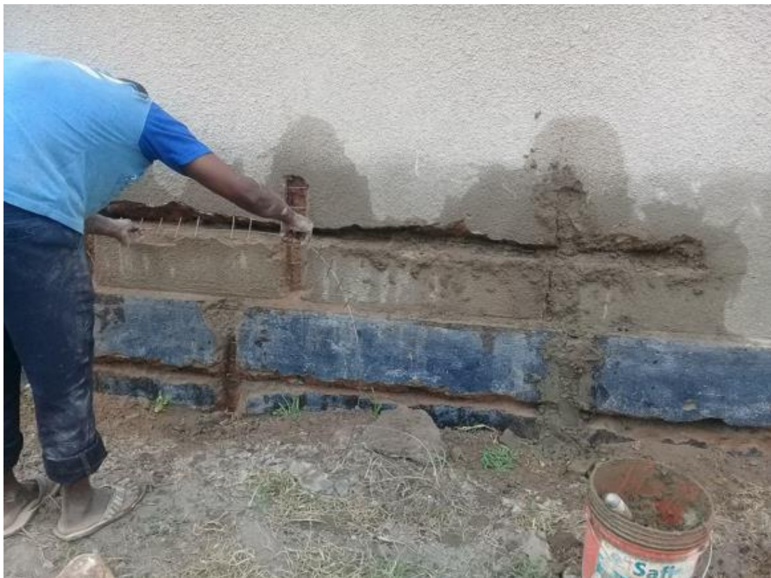
Risse im Mauerwerk werden ausgebessert
