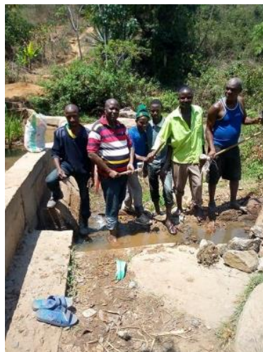
Die Sperre des Wassers wird beseitigt
