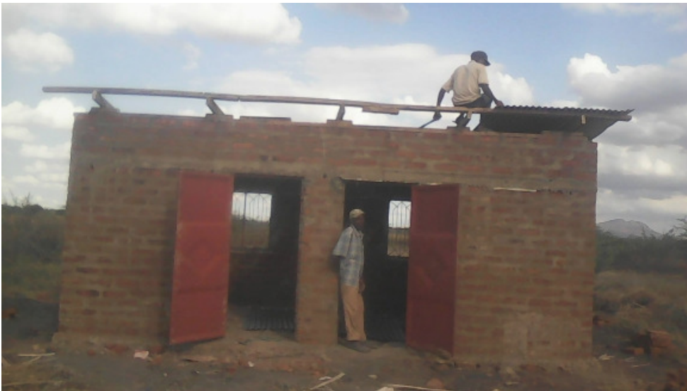
Neubau eines kleinen Büro- und Lagerraumes für die Wasserbenutzer-Organisation
