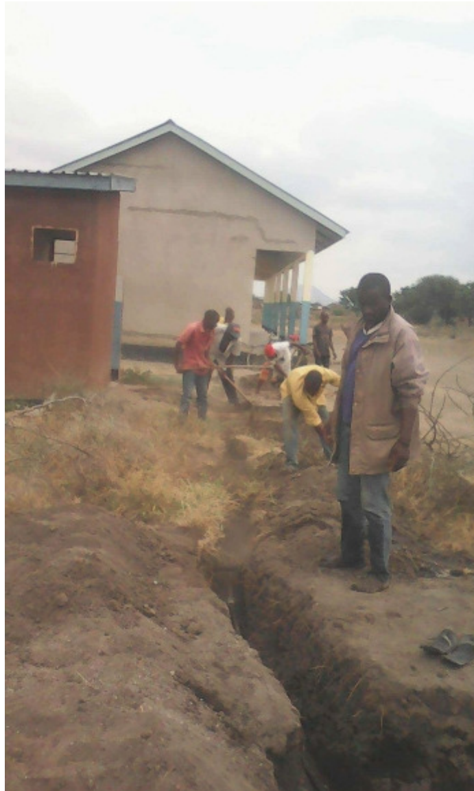
Arbeiten für die Wasserleitung zum Kindergarten
