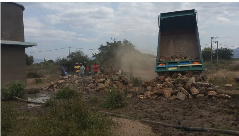
Sicherung des Geländes um den Hochtank durch grobes Felsgestein
