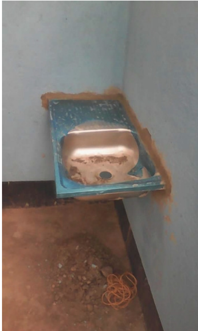
Neue Waschbecken im Sanitärgebäude des Kindergartens
