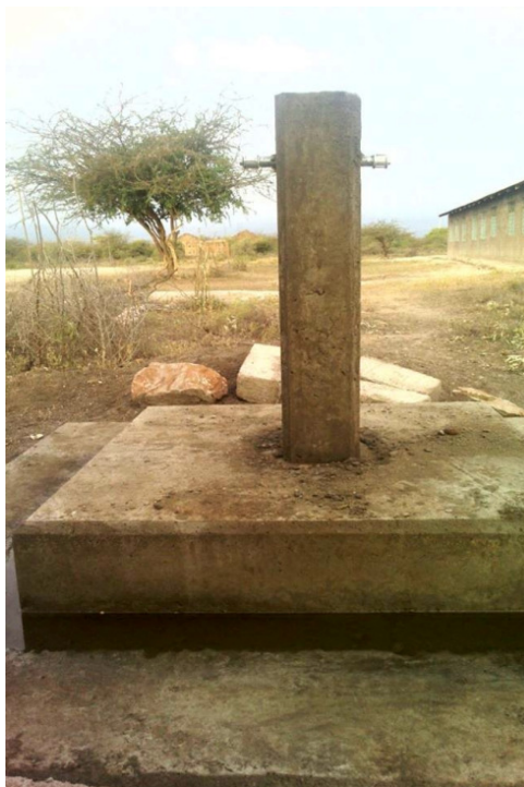
Eine neu erstellte Wasser-Zapfstelle in Toloha
